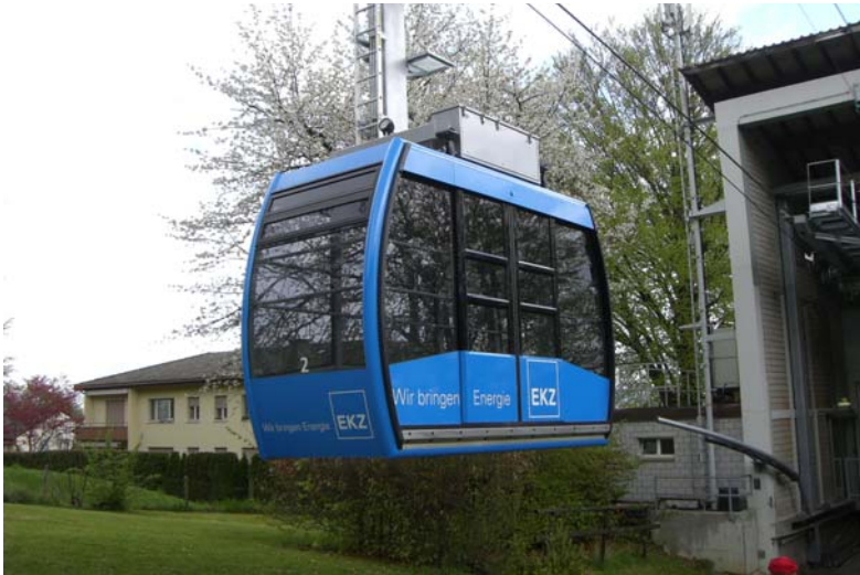
Bild 2 – Pendelbahn Adliswil – Felsenegg (VAROS 30+1)
